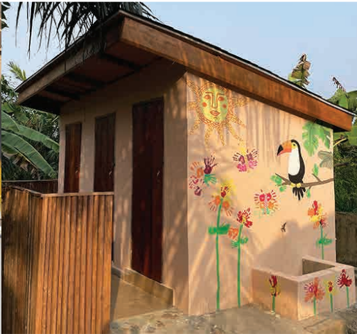
Gerenoveerd toiletgebouw in Ghana
